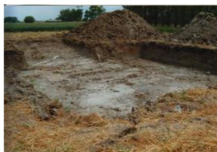
Figure 9 : Scrapage de la couche superficielle
