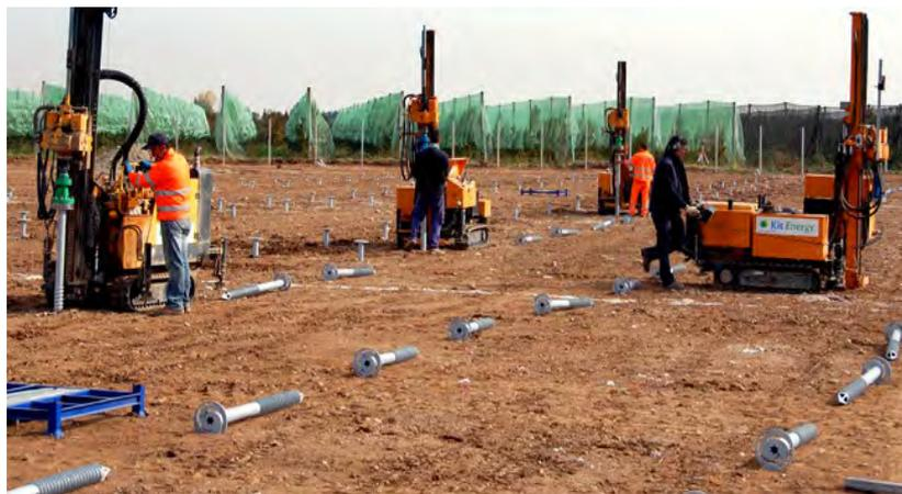
Fotografia 2. 5 – Maquinaria utilizada para a perfuração.
