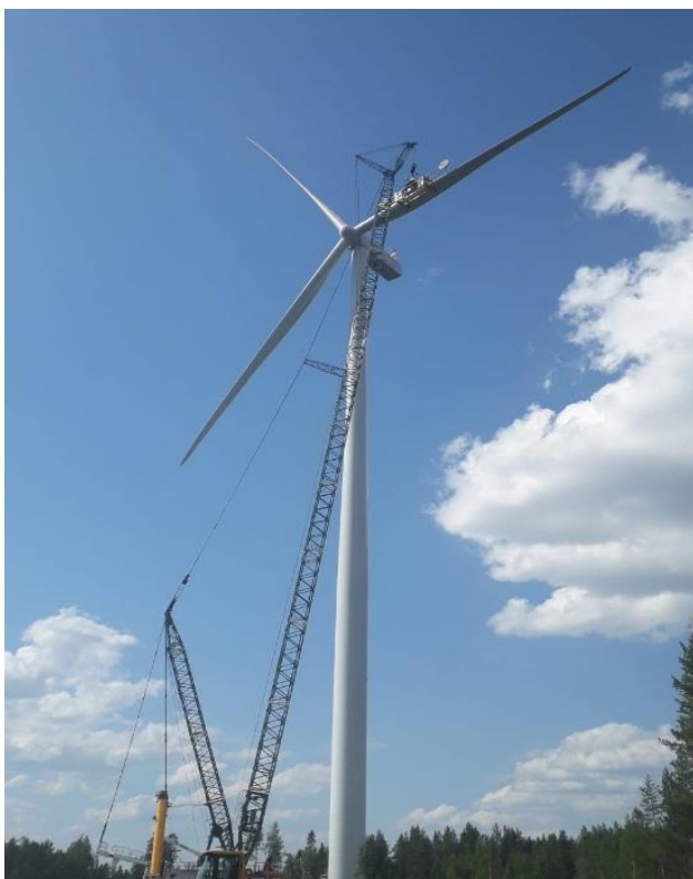
Piiparinmäki Construction Site Visit, 2022
