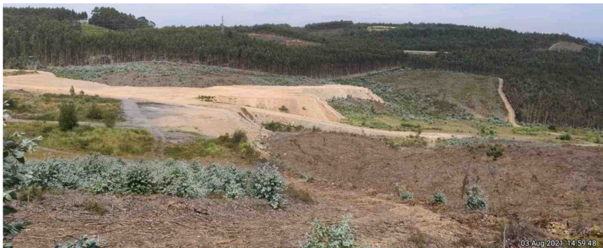
Fotografia 4.1 - Enquadramento da área da Central Fotovoltaica
