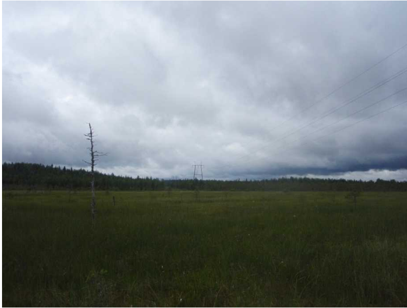
Kuva 5-41. Olemassa oleva voimajohtolinja Vuolijoen sähköasemalle ylittää Korkeamäensuon.
