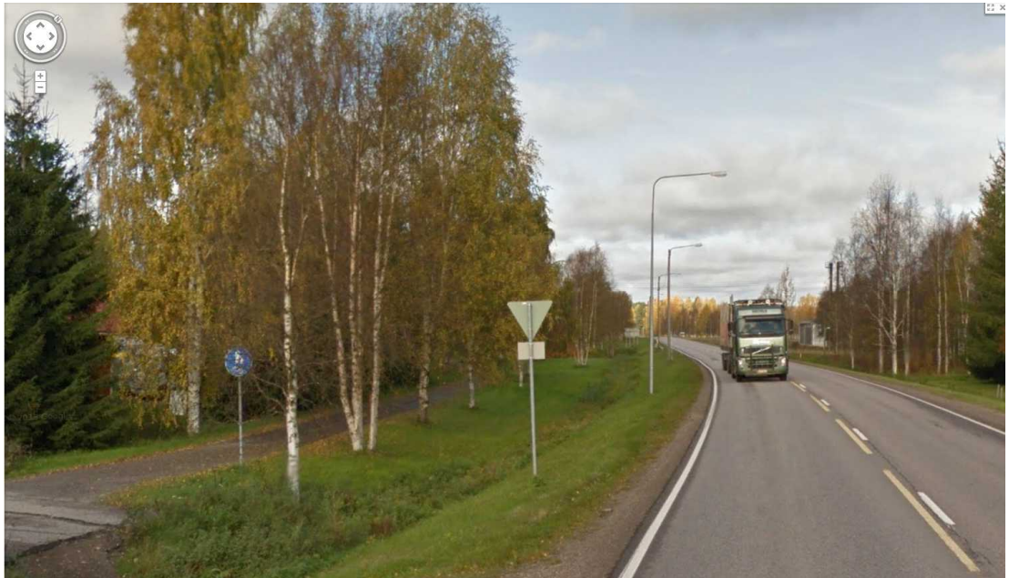
Kuva 5-83. Kantatie 88 Pyhännän kirkonkylän kohdalla. Vasemmalla kevyenliikenteenväylä.
